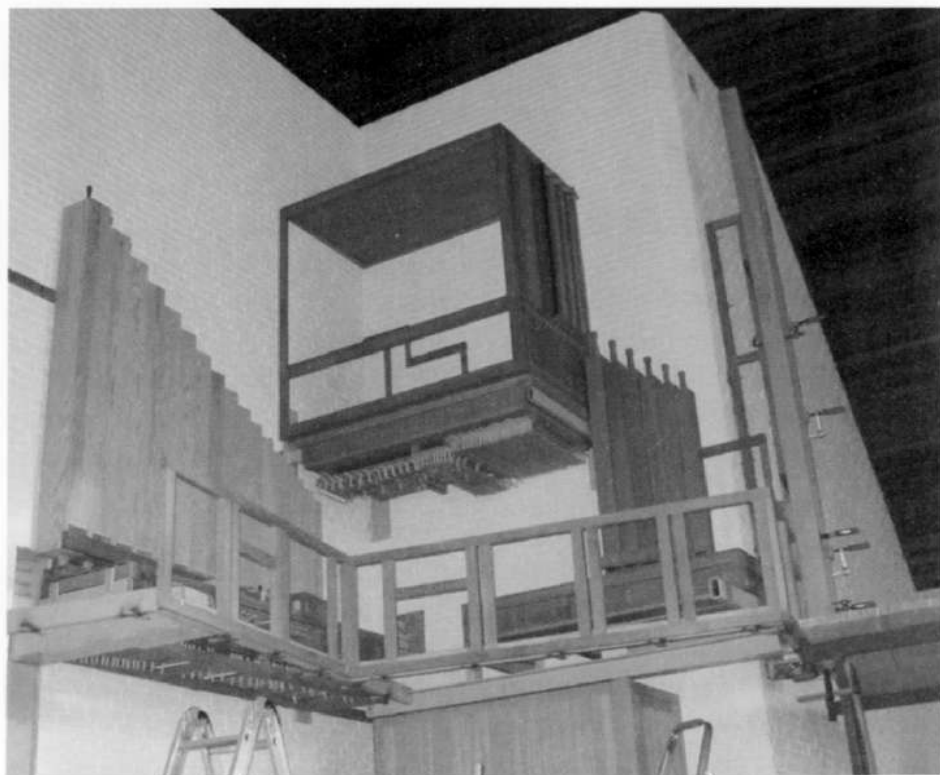
An die Stahlkonstruktion montierter Rahmen zur Aufnahme der Pfeifentürme
